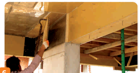
6 Не используется форменное масло. Не применяется на бетон, легко расклеивается бетона. Поэтому не нужна рабочая сила.
